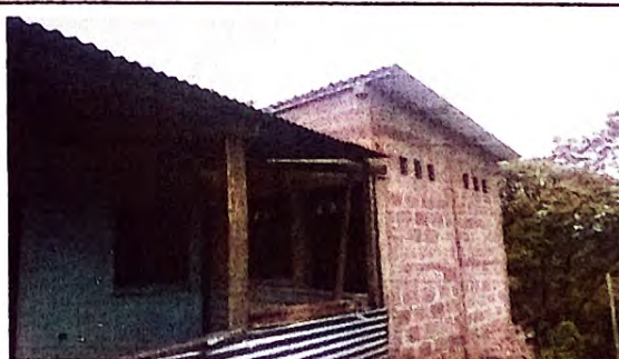
Foto 6: Finalización de cocina de frente
