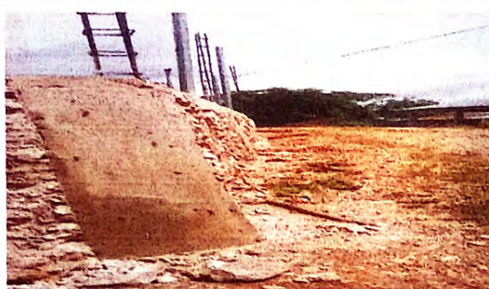
Foto 4: Finalización del muro perimetral
