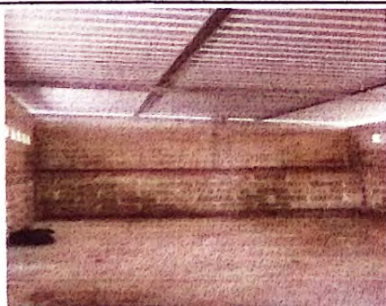
Foto 5: Finalización de la cocina por dentro.
